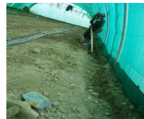
لږه ژوره کڼده د عایق فم یا بل شي د اښودلو لپاره چمتو ده
