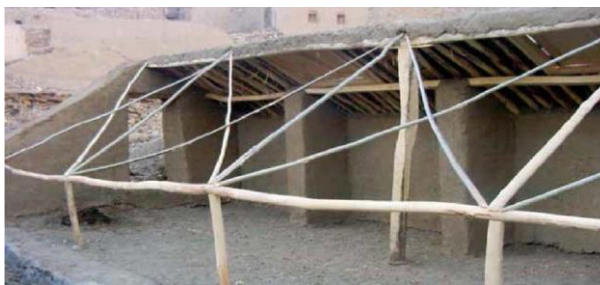
شنه خونه چي خټین دیوال یي باید د شمال په لور او د پلاستیک پواسطه پوښیدونکی سطحه یي باید د جنوب په لور وي چي د لمر زیاتي وړانگي تر لاسه کړي
