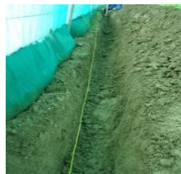
د شنی خونې د ننه د لږې ژورې کڼدې ایستل دکاک کاغذ یا Styrofoam د اښودلو لپاره
