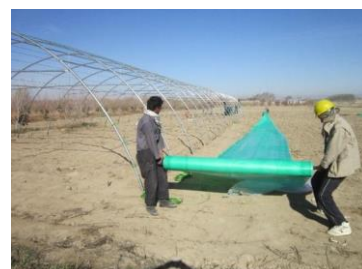
د فلزي اسکليت پوښل د پلاستيک پواسطه
